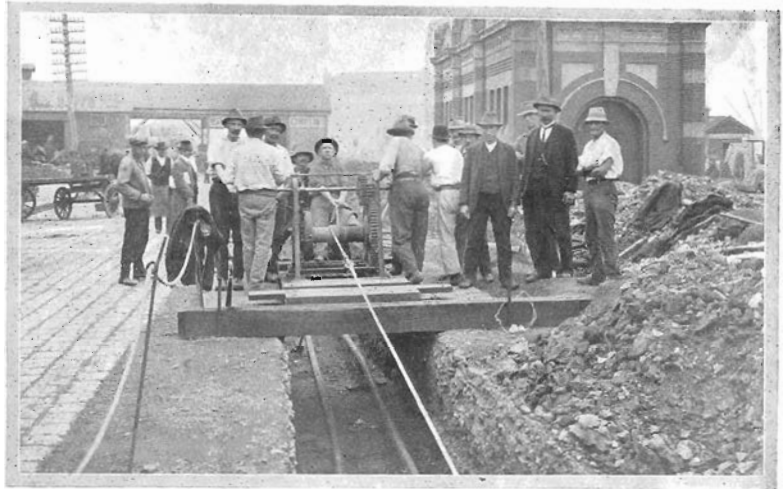
Laying 20,000 Volt Cables.
