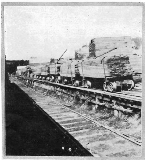
La La Timber Siding
